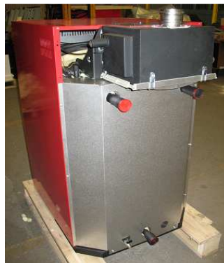
Condenseur à eau à l'arrière d'une chaudière à bûches (prototype)
